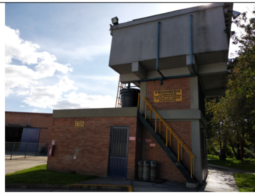
Foto No. 2. Ubicación del pozo en el predio
